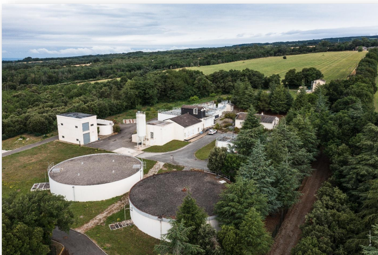
Usine d'eau potable des Barthes
