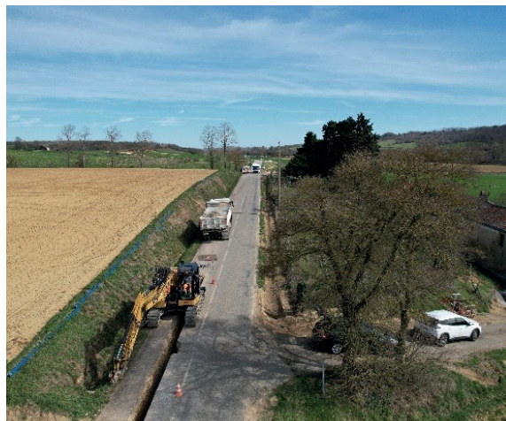
Réalisation des travaux de renouvellement de canalisation
