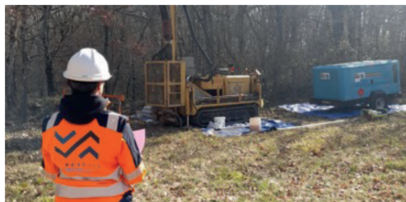
Réalisation de piézomètres
